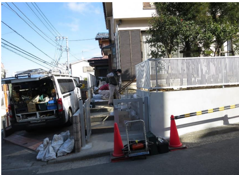
壁が取れました。エントランスを広げる工事の様子です
